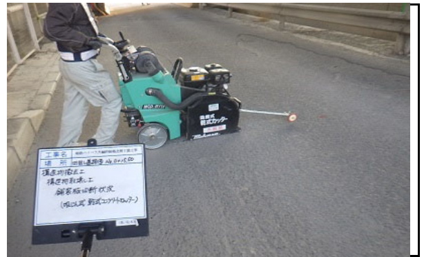
<環境配慮の施工> 吸塵式・乾式コンクリートカッター
