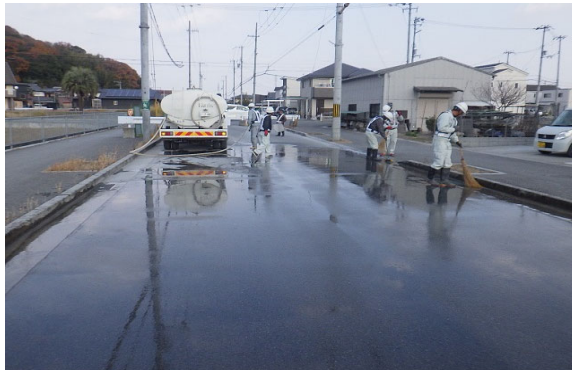
<清掃活動> 現場周辺の定期的な道路清掃
